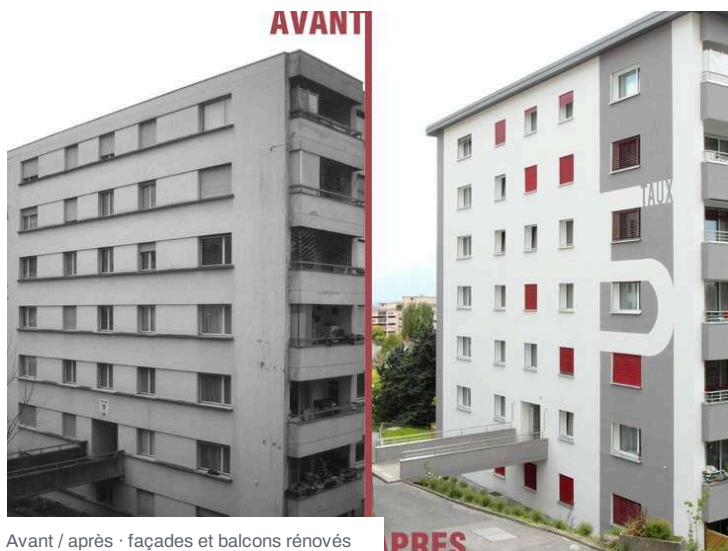
Avant / après · façades et balcons rénovés
